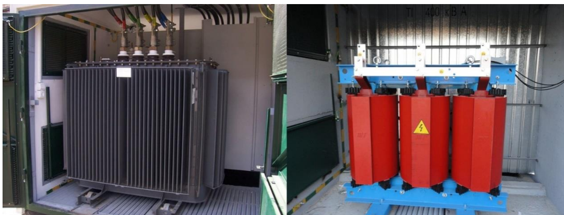
Рисунок 3 – Масляный (слева) и сухой (справа) трансформаторы
