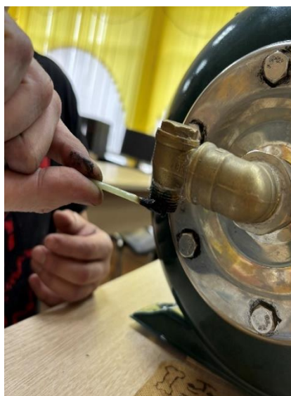
Рисунок 4 – Герметизация соединений
