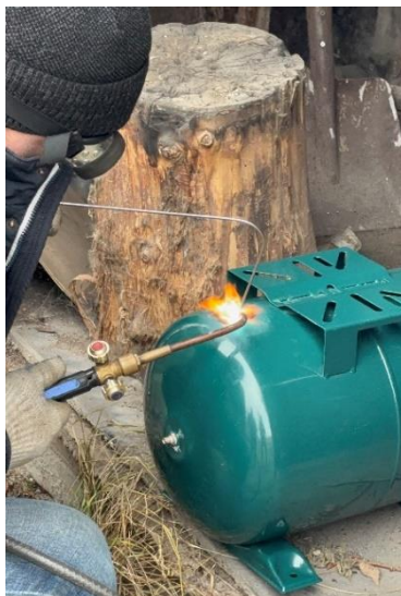
Рисунок 3 – Приваривание штуцера к СВД
